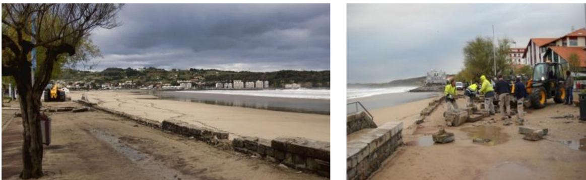
Figure 25 : Dégâts causés sur le perré d'Hendaye plage lors de la tempête du 9/11/2010.
